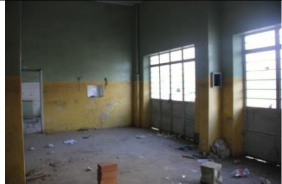
Vista interna Restaurante – Acesso pela R. Hercílio Luz
