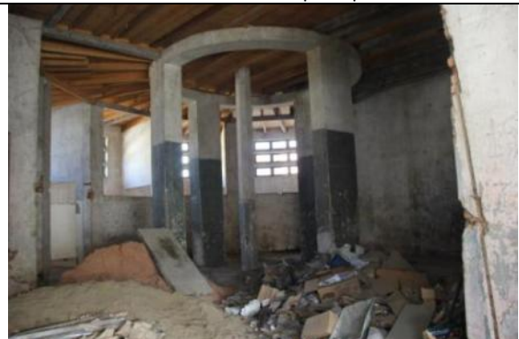
Vista interna Depósito Sacolão 2
