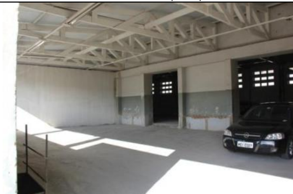
Vista interna Sacolão para o Hall principal
