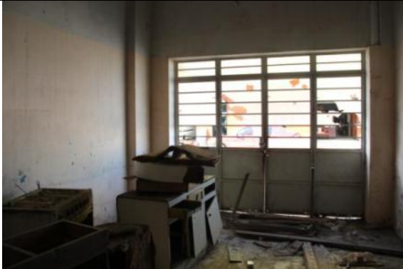
Vista interna Restaurante2 – Acesso pela R. Hercílio Luz
