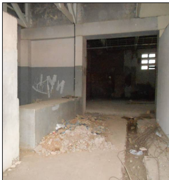
Fotos 14 e 15 - Mercado Público Municipal de Lages: pisos originais do tipo ladrilho hidráulico (E) e última banca em alvenaria, elementos remanescentes da construção original que devem ser preservados.
