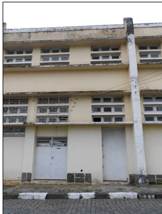
Fotos 07, 08 e 09 - Mercado Público Municipal de Lages: fachada junto à rua Monte Castelo, apresentando rachadura decorrente da abertura de porta posterior à construção (E), e vãos que tiveram a configuração original alterada.
