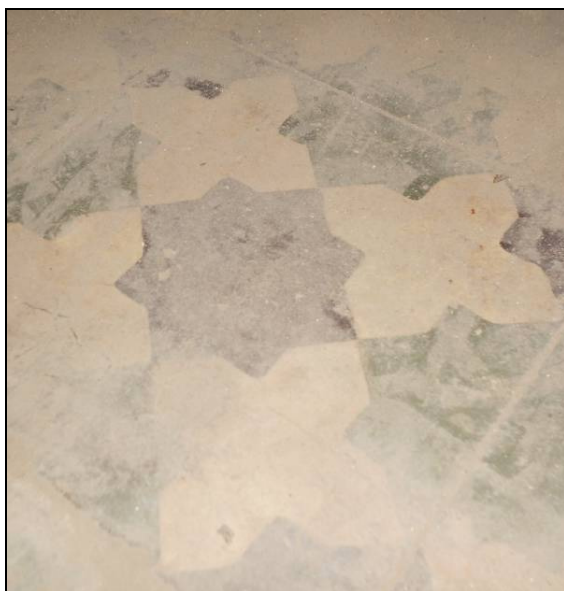
Fotos 14 e 15 - Mercado Público Municipal de Lages: pisos originais do tipo ladrilho hidráulico (E) e última banca em alvenaria, elementos remanescentes da construção original que devem ser preservados.
