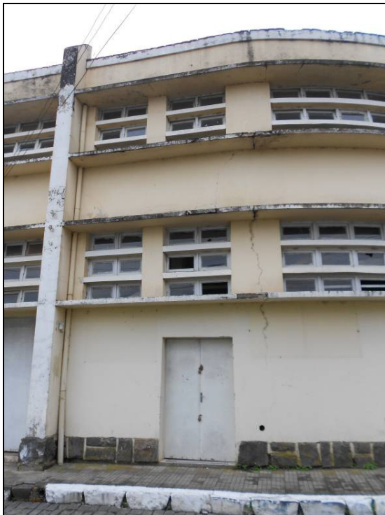
Fotos 07, 08 e 09 - Mercado Público Municipal de Lages: fachada junto à rua Monte Castelo, apresentando rachadura decorrente da abertura de porta posterior à construção (E), e vãos que tiveram a configuração original alterada.
