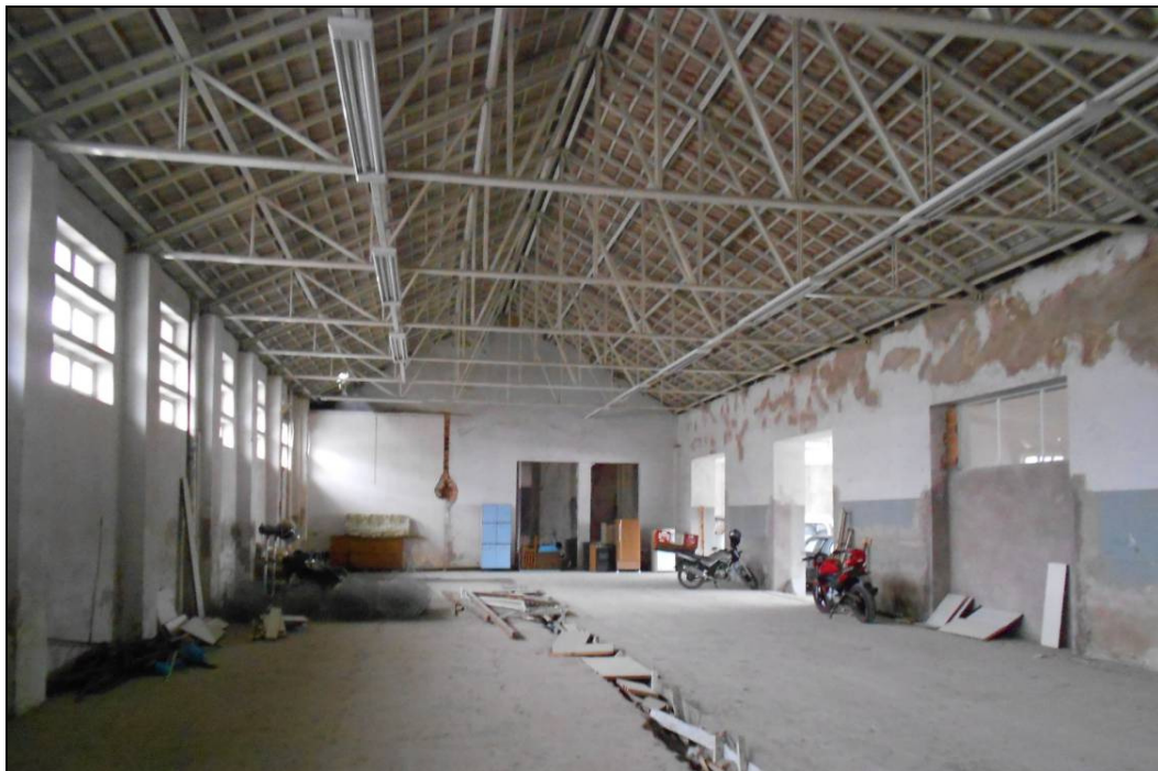
Foto 13 - Mercado Público Municipal de Lages: vista interna da ala principal, ora desativada, onde se localizavam as bancas. Notar as tesouras metálicas, que recentemente substituíram a estrutura original, em madeira.
