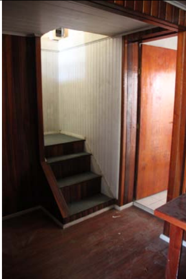
Sala Comercial – Acesso Mezanino
